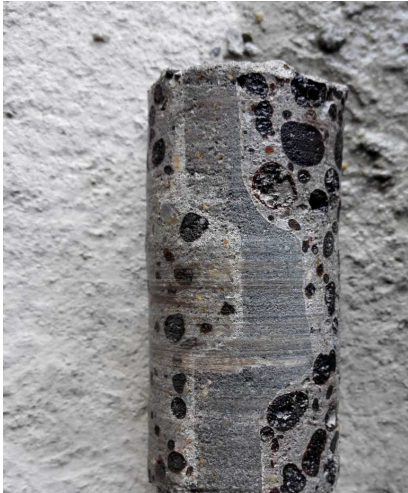
拼缝满浆满缝
